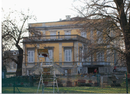
Villa a : Vista da est
