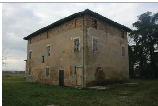
Vista da nord-est dell'edificio g
