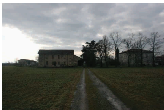
Vista del complesso dalla strada d'accesso a nord
