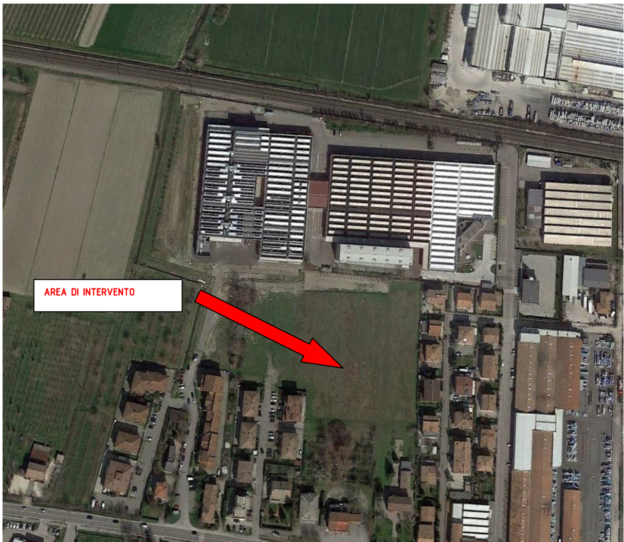
Vista aerea dell'area di intervento
