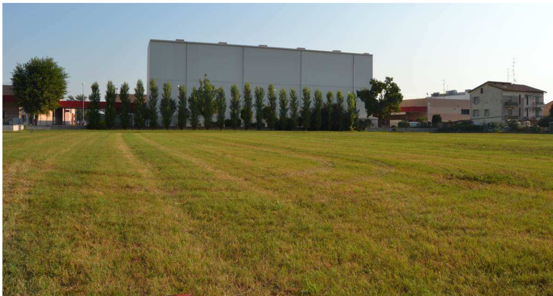
Figura 5 – Area di intervento a inizio lavori, da sud
