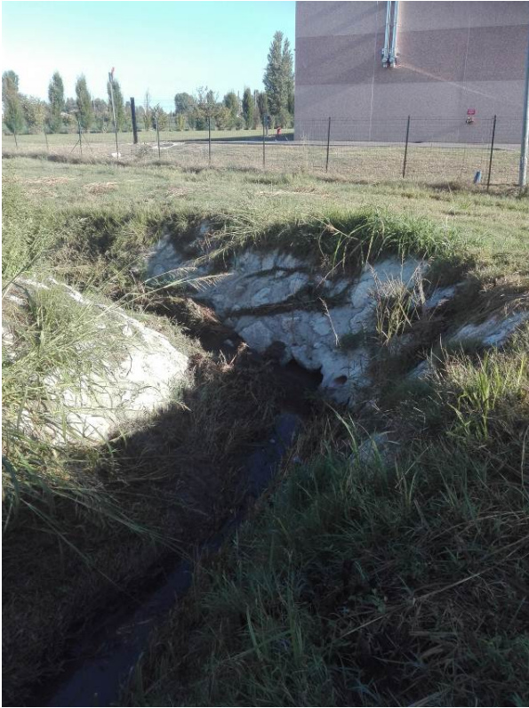
Manufatto di scarico esistente autorizzato – Cavo Tassarola 2°
