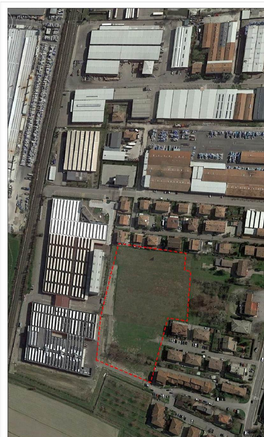
Vista aerea – area intervento ampliamento
