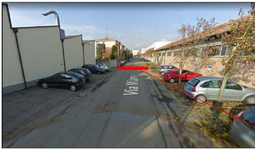
PUNTO DI VERIFICA TRAFFICO - VIA MILANO
