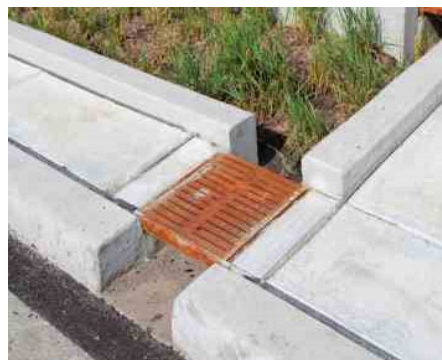
Fig. 23. Esempio pozzetto di sedimentazione (schema e fotografia)
