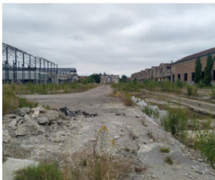
1. Vista verso nord, sullo sfondo il Blocco 26
