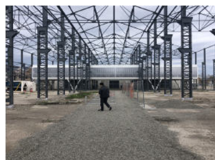
5. Vista verso nord, telaio capannone 15c
