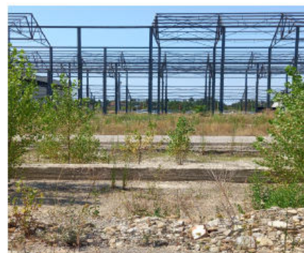
2. Vista verso ovest, telaio capannone 15 c
