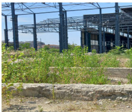
1. Vista verso ovest, capannone 15
