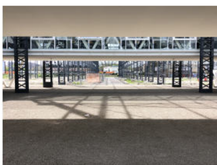
4. Vista verso sud, telaio capannone 15c
