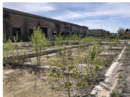
5. Vista verso sud, tracce fondazioni
