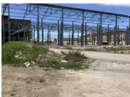
3. Vista verso nord-ovest, telaio capannone
