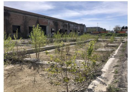
5_Vista verso sud, tracce fondazioni
