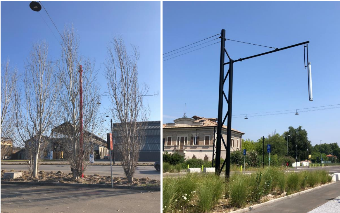
Figura 19 – Foto del sistema a tesate già realizzato in viale Ramazzini e Piazzale Europa.
