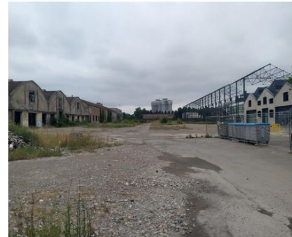
2_Vista verso sud, sullo sfondo il fascio ferroviario linea MI-BO
