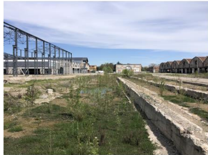
4_Vista verso nord, sullo sfondo il Blocco 26
