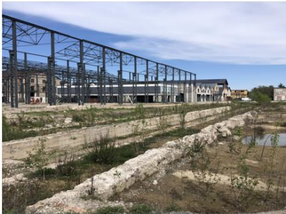
3_Vista verso nord, sullo sfondo il Blocco 26
