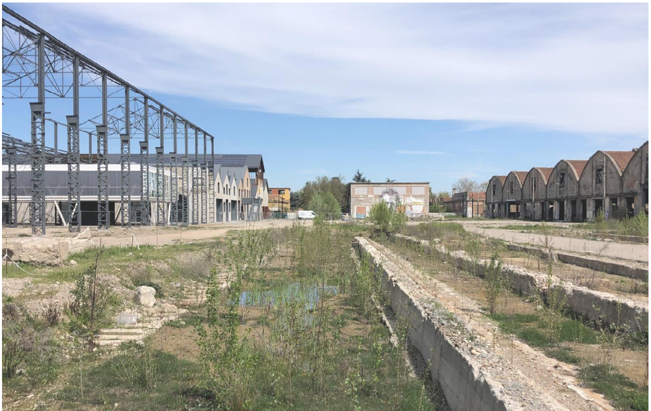
Figura 10 – Foto dello stato di fatto.
