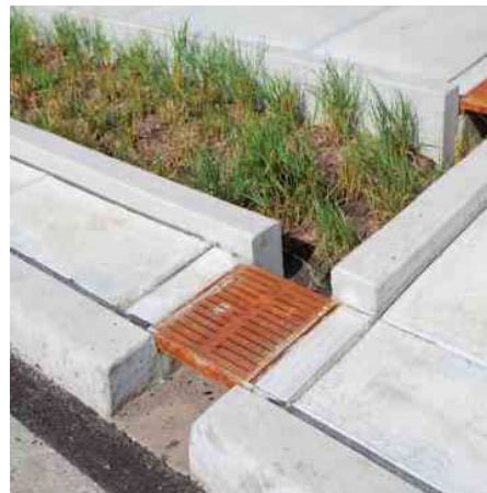
Fig. 9. Esempio pozzetto di sedimentazione (schema e fotografia)
