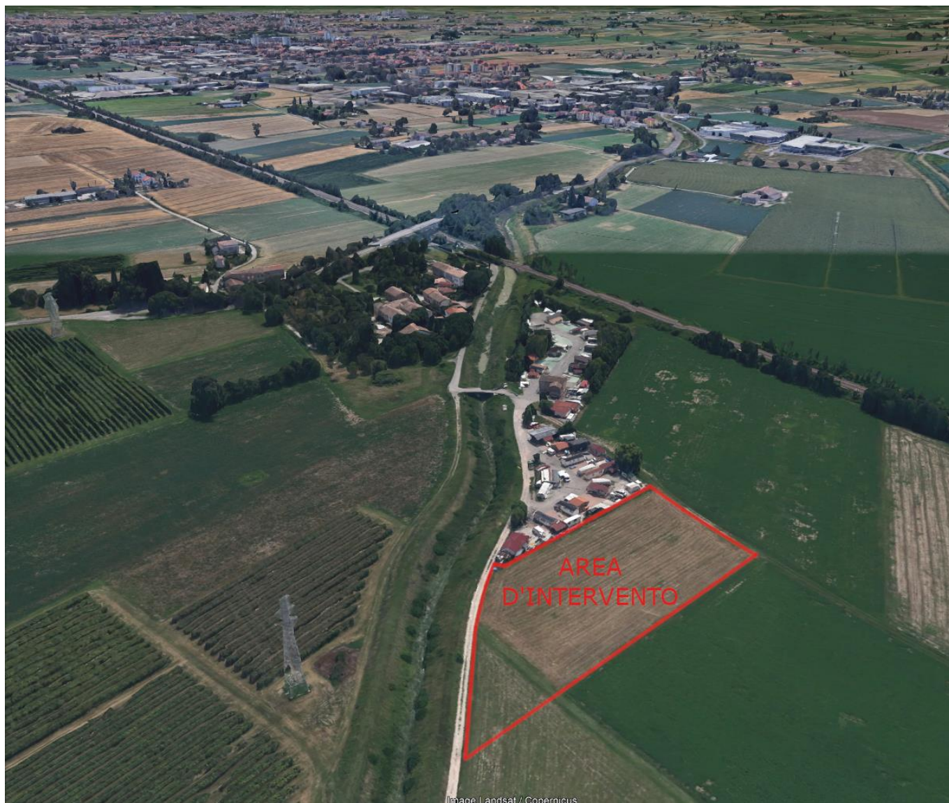
Vista a volo d'uccello – orientamento Sud-Est
