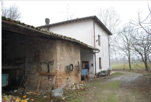
Edificio abitativo, ristrutturato, a pianta quadrata su due livelli, coperto a quattro falde. Ad esso è addossato, ad est, un basso servizio, a pianta rettangolare su un livello, coperto a due falde: questo corpo di fabbrica non è stato ristrutturato. Il complesso non è soggetto a tutela.
