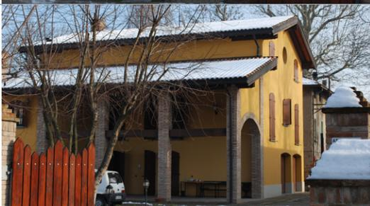
Edificio "rustico": Rustico ristrutturato per l'uso residenziale e in buona misura ricostruito; attualmente mostra una pianta rettangolare sviluppata su tre livelli con tetto a due falde. È stato mantenuto il portico architravato originariamente presente sul prospetto ovest.
