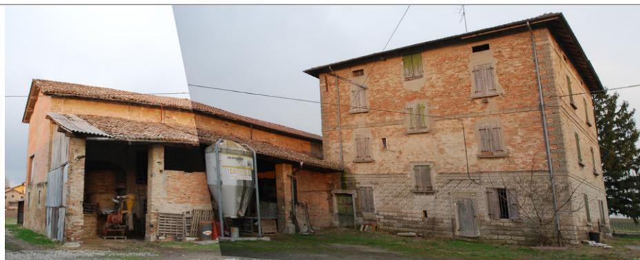
**DESCRIZIONE** Edificio a corpi congiunti; si compone di una casa quadrata di impianto compatto con copertura a padiglione e di un rustico dalla pianta allungata con tetto a due falde; i due edifici sono aggregati attraverso un lungo portico/tettoia architravato e collegato con il fronte nord della casa quadrata e il fronte sud del rustico. Il paramento della casa quadrata mostra uno zoccolo bugnato, conci decorativi ad imitazione di irrigidimento degli spigoli e fasce marcapiano.
