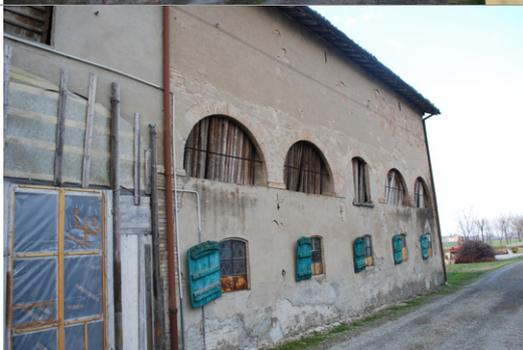
Edificio **a**: prospetto est del corpo rustico con particolare del portico parzialmente tamponato.
