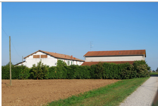
Vista del complesso da ovest
