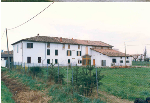
Foto Costa cod. 15B2-2 Edificio a : vista da nord
