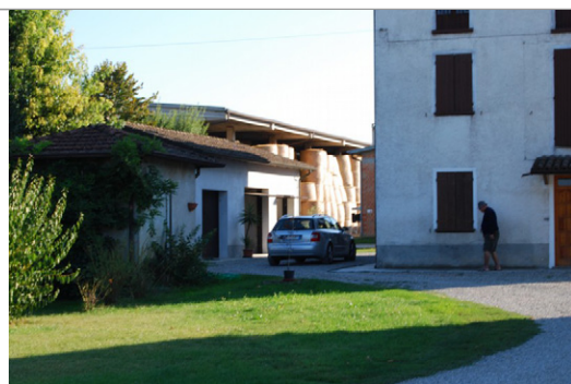
Vista da nord : da sinistra il basso servizio, l'autorimessa e l'abitazione, non tutelati
