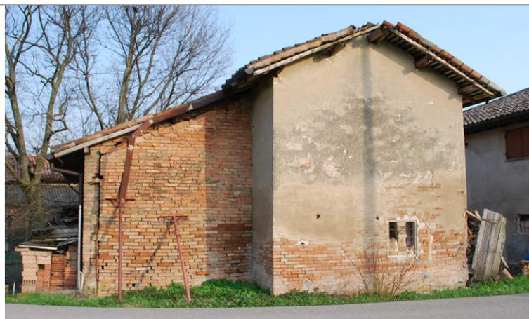
**DESCRIZIONE** Bassi servizi composti da un piccolo edificio a pianta rettangolare con tetto a due falde, ampliato sul prospetto nord con un corpo coperto a falda unica.
