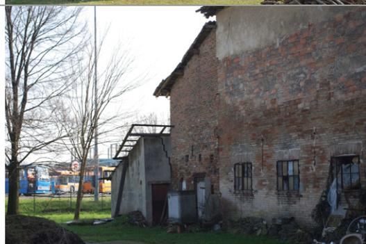
Edificio **b**: prospetto nord con particolare del corpo congiunto con coperto a falda unica e basso servizio incongruo.
