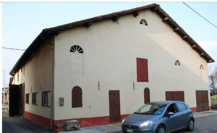
**DESCRIZIONE** Rustico stalla/fienile di pianta quadrangolare compatta con copertura a capanna; sulla testata nord sono congiunti bassi servizi con tetto a falda unica.
