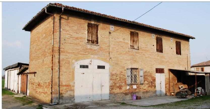
**DESCRIZIONE** Casa bracciantile di pianta rettangolare sviluppata su due livelli e con tetto a tre falde; la parte rustica del piano terra è disposta a ponente e mostra una luce ad arco a sesto ribassato.
