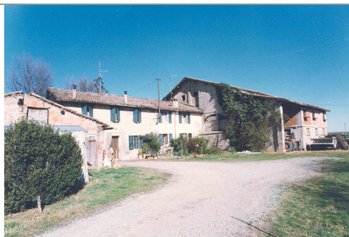
Foto Costa 02D05-1 Edificio a , vista da sud-ovest
