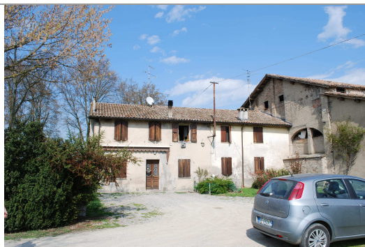
Edificio a : prospetto sud della parte abitativa
