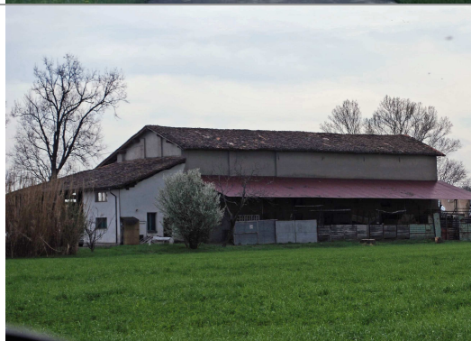
Edificio b : vista da nord
