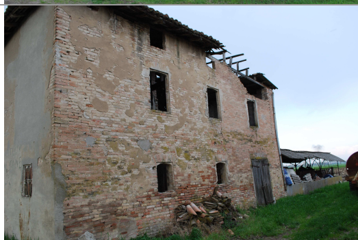
Edificio b : prospetto est
