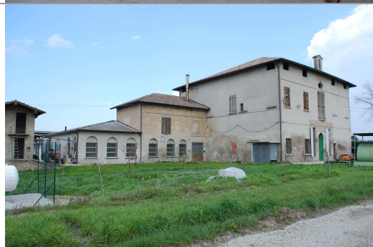
Edificio c : vista da nord-ovest
