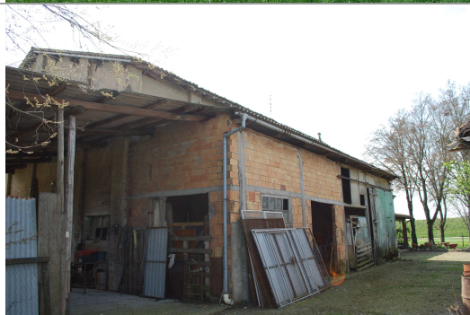
Edificio a : vista da nord-est del rustico
