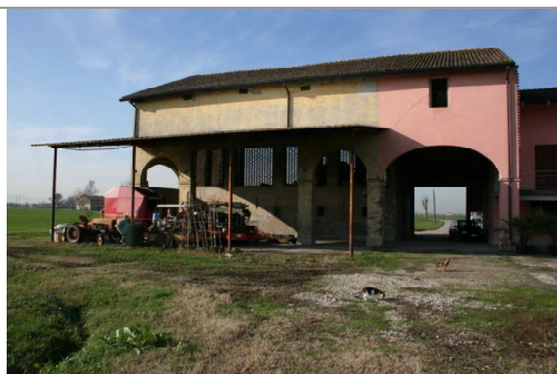
Prospetto est del rustico, con portico a luci archivoltate. Le due luci centrali sono state unite e architravate.
