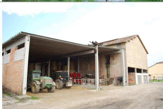
Edificio e : vista da nord-ovest.
