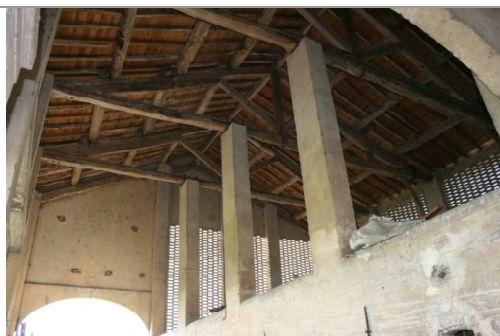
Particolare della copertura del fienile
