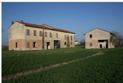
Vista del complesso da sud
