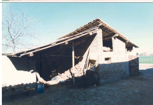
Foto Costa 02D05-3 Edificio b , vista da sud
