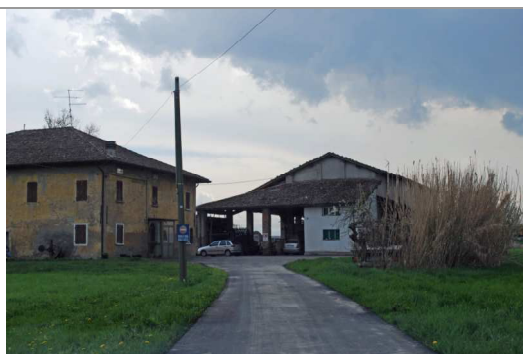
Vista del complesso da nord
