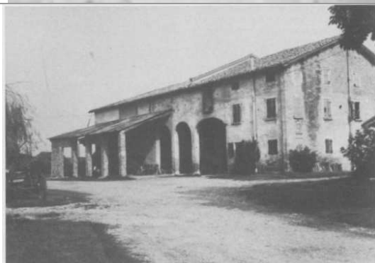
Foto Baricchi 517, si nota la tettoia non tamponata
