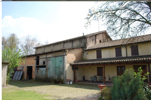
Vista dell'edificio a da nord-ovest
