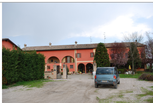
Prospetto sud dell'edificio
