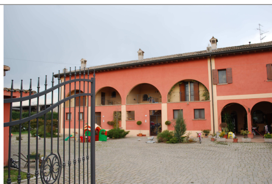
Vista del rustico con le quattro luci archivolte, tamponate.
