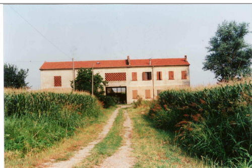
Foto Leonardi cod. 02D07-1 Vista edificio a da ovest
