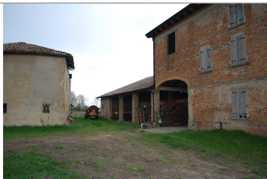
Vista del complesso da ovest
