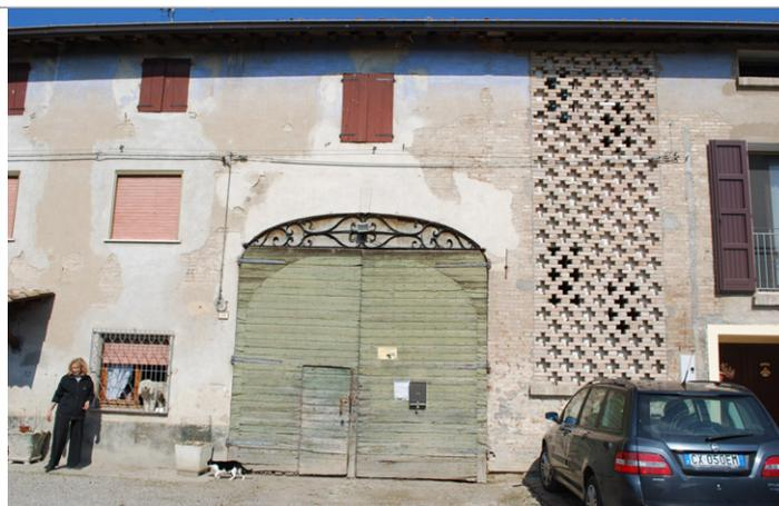
**DESCRIZIONE** Edificio a corpi giustapposti con porta morta a sesto ribassato, sviluppato su due livelli e sottotetto, con copertura a due falde e colmo indifferenziato; il corpo rustico stalla/fienile era disposto a levante, attualmente adibito ad uso abitativo. Sulla testata ovest è aggregato un piccolo basso servizio coperto a due falde.
