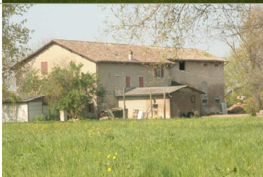
Vista dell'edificio a da nord-ovest
