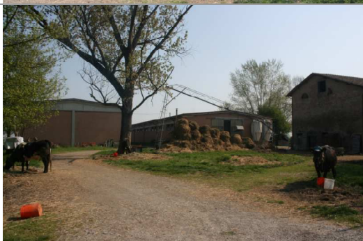
Vista dei due capannoni prefabbricati (stalla e fienile)
