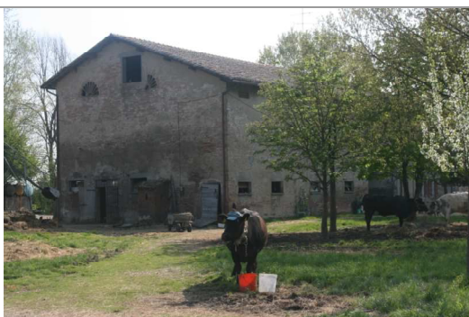
Vista da ovest della parte a rustico dell'edificio
