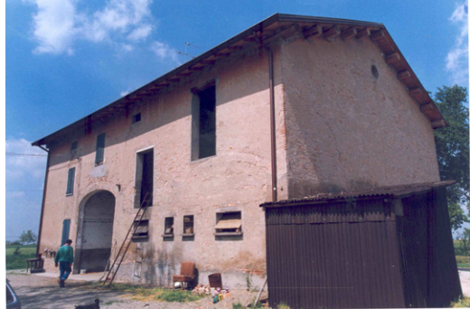
Foto Costa cod. 27C04-1 Vista dell'edificio a da sud
