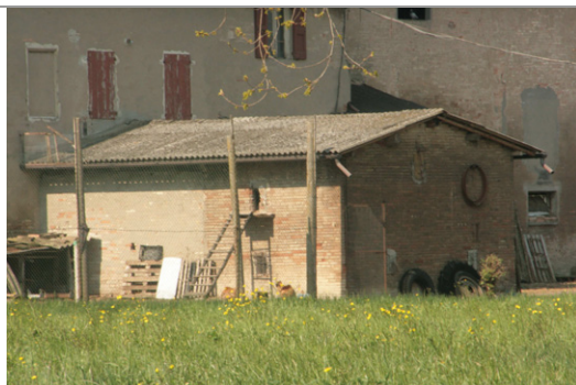
Particolare del basso servizio addossato all'edificio a nord
