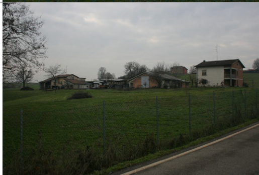
Vista da est dell'edificio e di quelli circostanti
