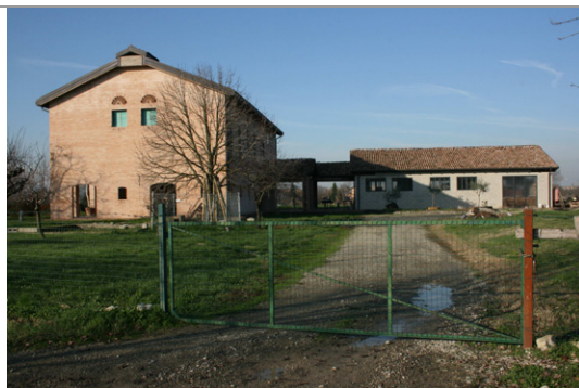
Vista da est dell'edificio e del basso servizio (non soggetto a tutela) ricostruito a sud.
