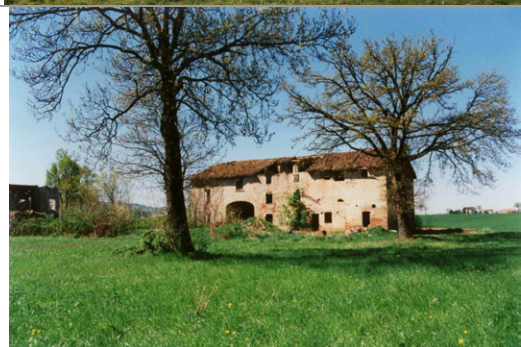
Foto Leonardi cod.28D16-1 Vista dell'edificio da est: si vede la parte di edificio crollata, corrispondente alla porta morta.
