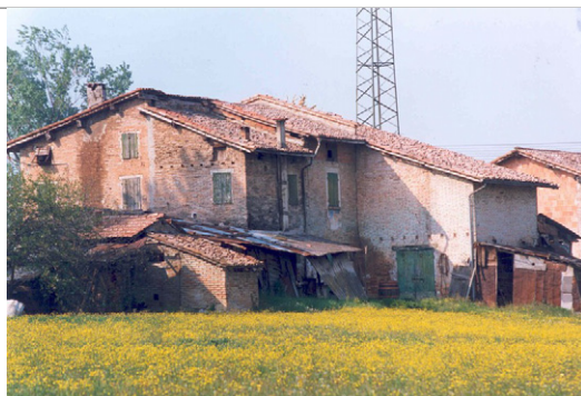
Foto Costa cod. 28B34-1 Vista del complesso da sud
