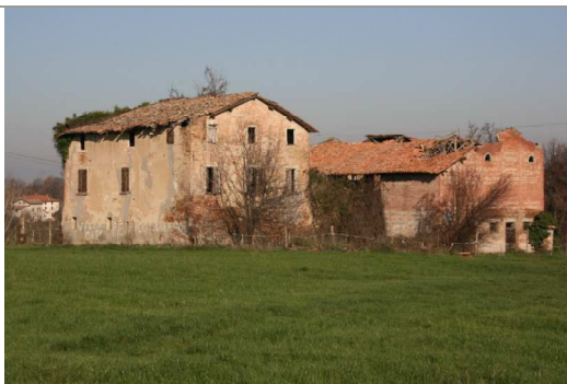
Vista del complesso da sud
