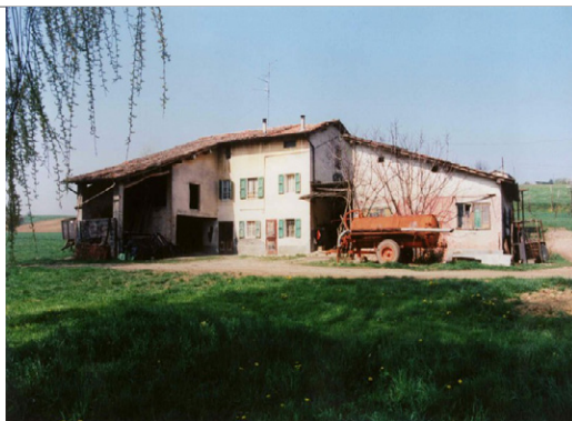
Foto Leonardi cod. 21D25-1 Vista da sud dell'edificio
