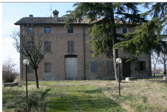
Prospetto principale est, dell'edificio
