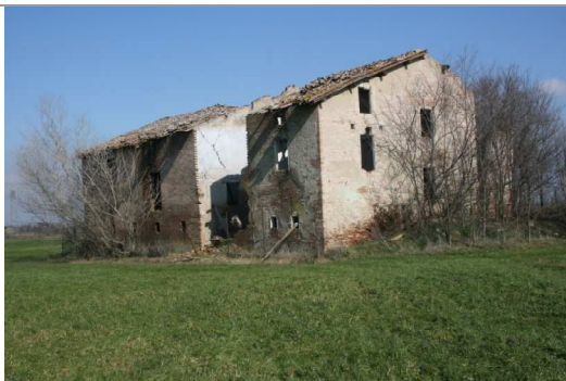
Vista dell'edificio da sud-ovest
