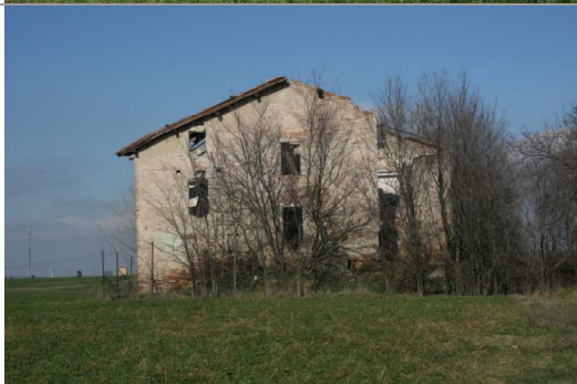
Vista del fronte sud
