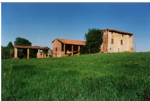
Foto Leonardi cod. 28B26-3 Vista del complesso da ovest
