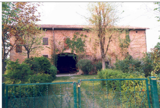
Foto Costa cod. 28C03-1 Prospetto sud prima della ristrutturazione
