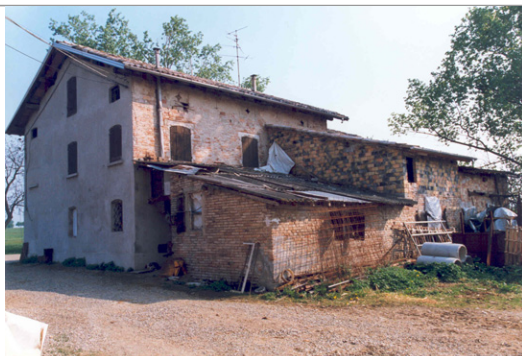
Foto Costa 28B12-4 Edificio a : vista da nord
