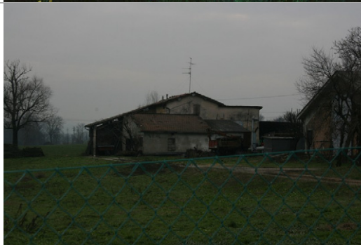
Vista da est dell'edificio
