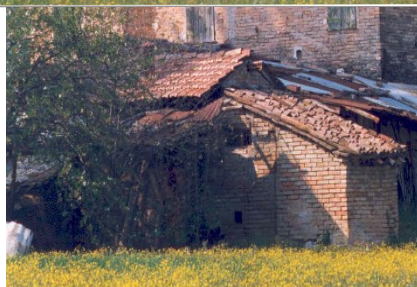
Basso servizio connesso all'edificio a porta morta tramite tettoie con copertura in lamiera. La parte originale dell'edificio è quella individuata nel sedime del catasto d'impianto. Edificio non soggetto a tutela.
