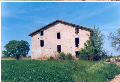
Foto Costa cod. 28D16-2 Fronte est dell'edificio
