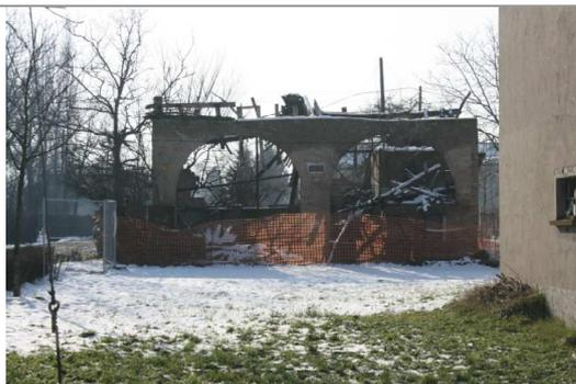
Edificio **b** : Barchessa la copertura e parte delle mura sono crollate
