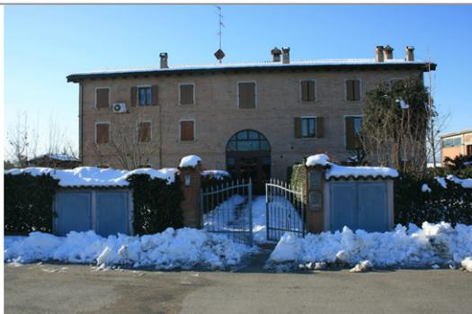
Vista del prospetto nord dell'edificio. Si notano le modifiche apportate con la ristrutturazione: la porta morta è oggi più stretta e a tutto sesto, il terzo piano è stato alzato comportando anche modifiche alle aperture.
