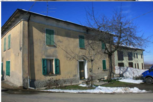
Vista da sud-est della parte sud dell'edificio a
