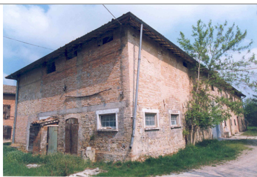
Foto Costa cod. 35B01-1 Vista da sud dell'edificio a porta morta
