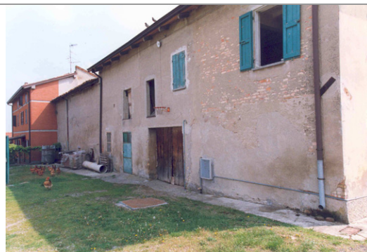
Foto Costa cod. 35B20-2 prospetto ovest dell'edificio a , visto da sud-ovest; visibile la parte centrale prima della ristrutturazione
