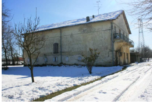
Vista dell'edificio da nord-ovest
