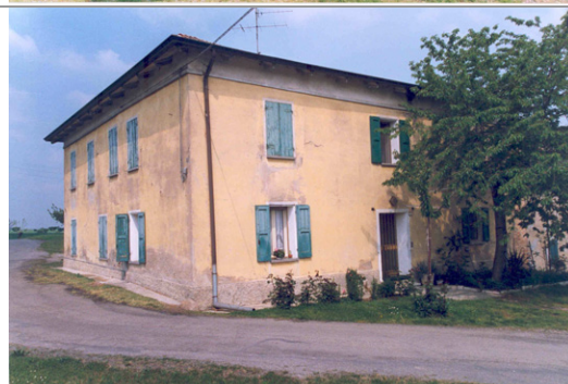
Foto Costa cod. 35B20-5 parte dell'edificio a tuttora non ristrutturata
