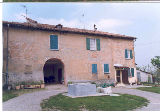
Foto Costa cod. 35B20-3 parte nord dell'edificio a prima della ristrutturazione
