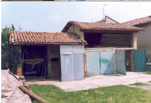
Foto Costa cod. 35B20-1 basso servizio ad ovest del complesso
