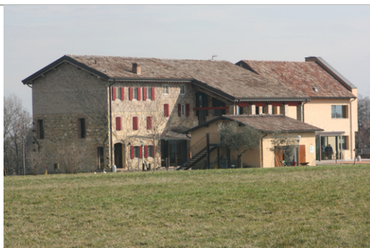
Vista da sud-ovest dell'edificio a
