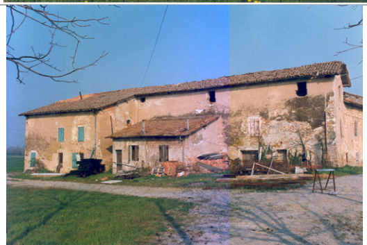
Foto Costa cod. 36A5-2 Edificio a , prospetto ovest
