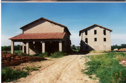
Foto Leonardi cod. 36B20-1 Vista del complesso da sud; si vede come i due fabbricati fossero in origine più vicini.
