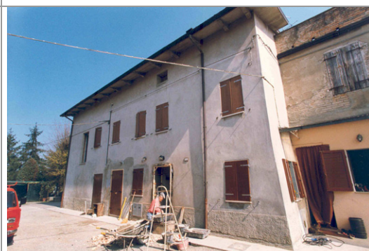
Foto Costa cod. 36B10-3 Vista dell'edificio a da nord-ovest
