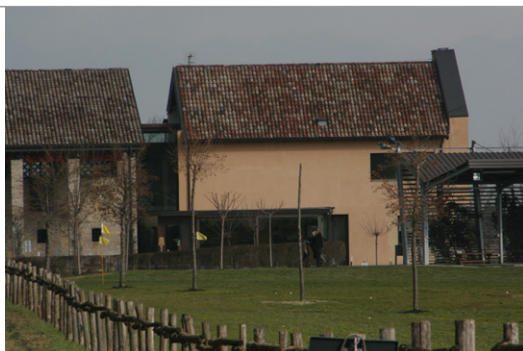
Porzione di fabbricato nuova (non vincolata), realizzata durante l'intervento di ristrutturazione e ampliamento del complesso.
