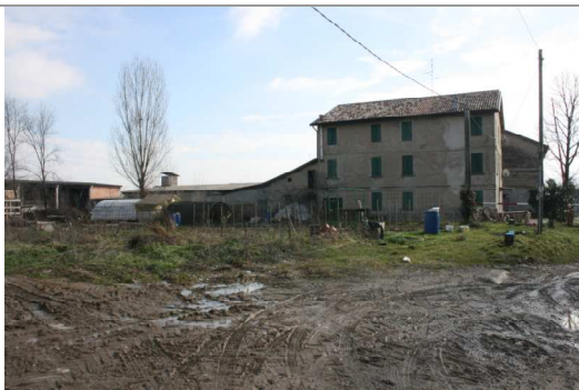
Vista da ovest dell'edificio a
