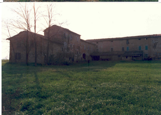
Foto Costa cod. 36A5-4 Edificio a visto da nord-est
