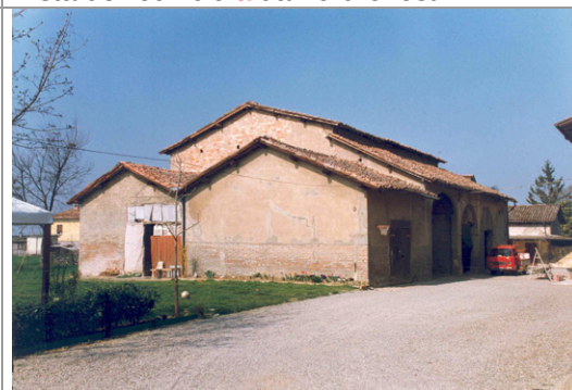
Foto Costa cod. 36B10-5: Vista del rustico (edificio b ) da sud
