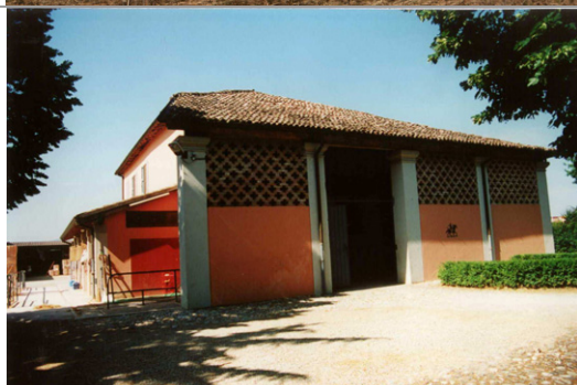
Foto Leonardi cod. 36B14-3: vista da nord dell'edificio a
