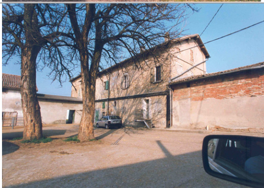
Foto Costa cod. 36A08- 4 Edificio a
