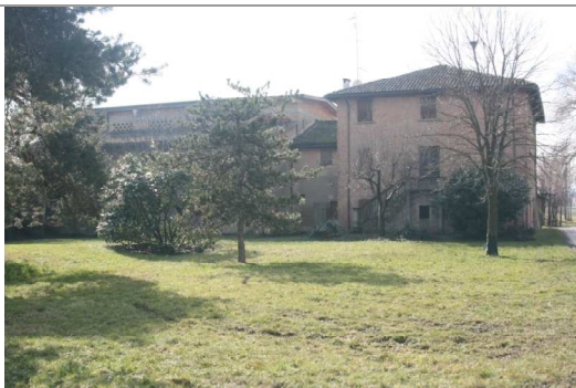
Vista da nord dell'edificio a (a sinistra il rustico non tutelato)
