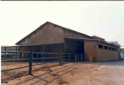
Foto Costa cod. 36A10-1: parte rustica dell'edificio a , vista da est; sulla destra li corpo più recente addossato (non vincolato)
