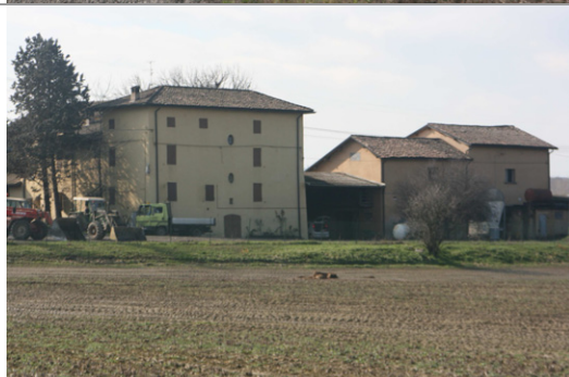
Vista dell'edificio a da nord-est; a destra il rustico connesso, non soggetto a tutela
