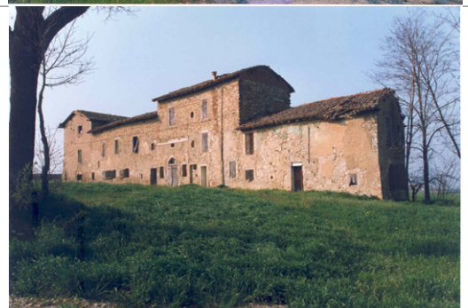
Foto Costa cod. 36A5-3 Edificio a , prospetto sud
