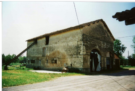
Foto Leonardi 36A09-2 Vista da nord del fabbricato b
