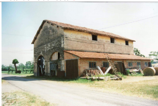
Foto Leonardi 36A09-3 Vista da sud del fabbricato b
