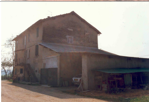
Foto Costa cod. 36B16-2 Vista da nord-ovest dell' edificio a
