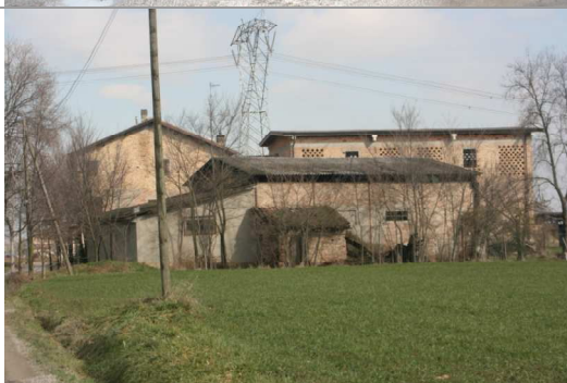
Vista del complesso da sud
