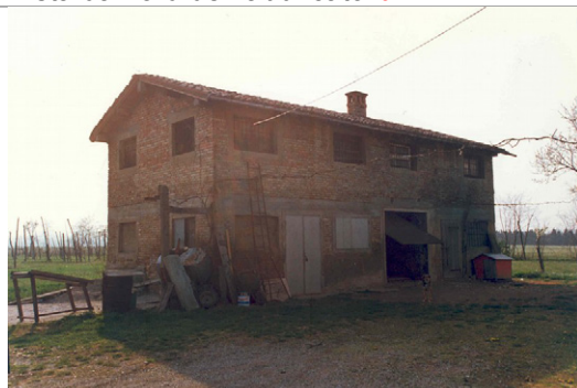
Foto Costa cod. 36A09-4 Basso servizio (non tutelato) che ha subito differenti rimaneggiamenti
