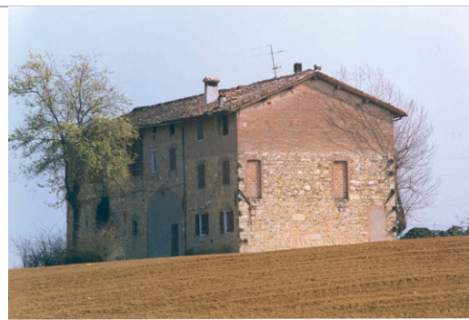
Foto Costa cod. 36B21-1 Vista da nord-ovest dell'edificio a
