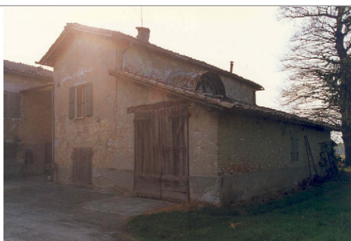
Foto Costa cod. 36A09-2 Vista del fabbricato a nord dell'edificio a , attualmente ristrutturato
