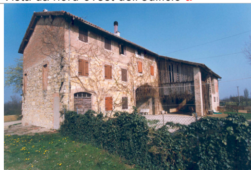
Foto Costa cod. 36B21-2 Vista da sud-ovest dell'edificio a
