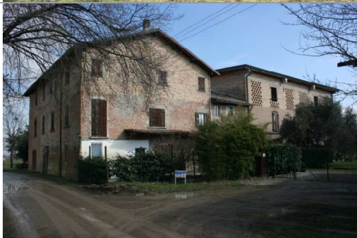
Vista da sud-ovest dell'edificio a (a destra il rustico non tutelato)
