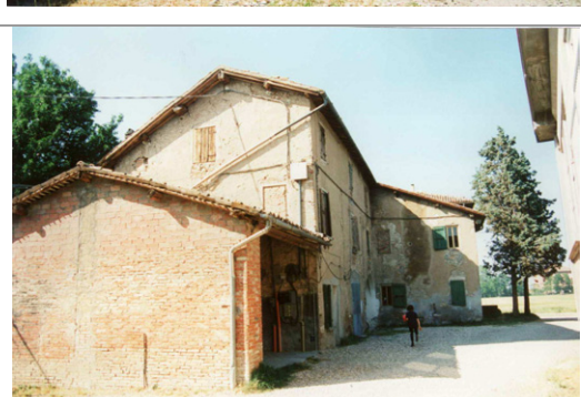
Foto Leonardi cod. 36A08-2 Edificio a visto da sud
