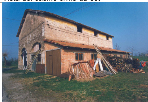
Foto Costa cod. 36A09-5 Vista del fienile da sud
