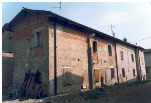
Foto Costa cod. 16D24-6 Edificio b : Vista da sud-ovest
