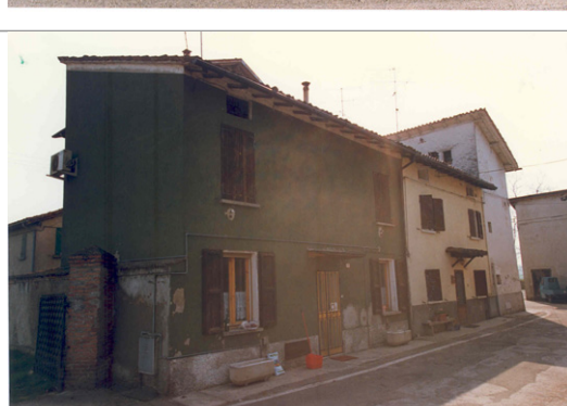
Foto Costa cod. 16D24-10 Edificio e : vista da ovest
