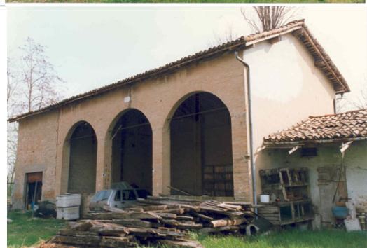
Foto Costa cod.16D27-5 Edificio b prima della ristrutturazione, vista da nord-ovest.
