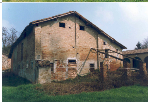
Foto Costa cod. 16D27-4 Edificio rustico prima della ristrutturazione, vista da sud-ovest.
