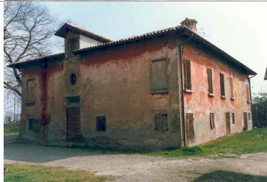
Foto Costa cod. 16D27-8 Edificio a : vista da nord-est.
