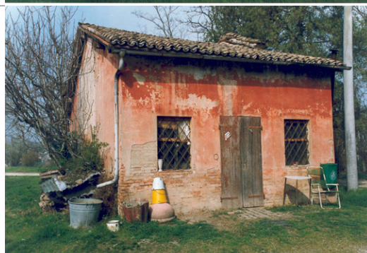
Foto Costa cod. 16D27-1 Basso servizio rilevato nel censimento Costa; la cartografia catastale e BTU non ne mostrano la collocazione. Dalle viste a volo d'uccello si rileva l'attuale presenza di un basso servizio con copertura differente, a falda unica, collocato nell'area cortiliva di fronte alla testata sud dell'edificio rustico sottoposto a ristrutturazione.
