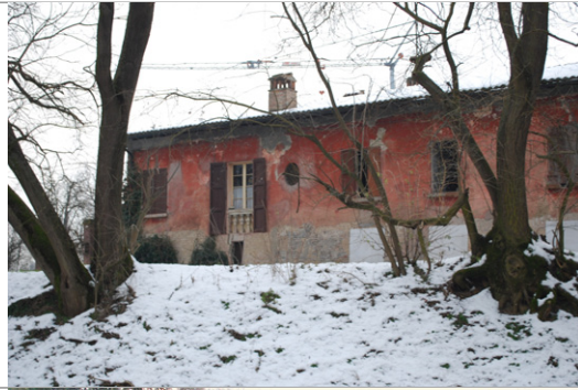
Edificio a allo stato attuale: vista da nord.
