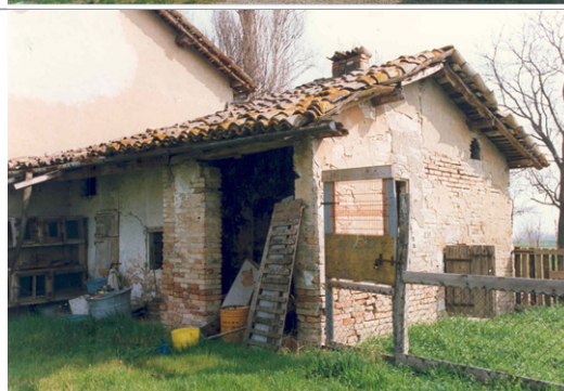
Foto Costa cod. 16D27-6 Edificio b prima della ristrutturazione, corpo congiunto in direzione sud.
