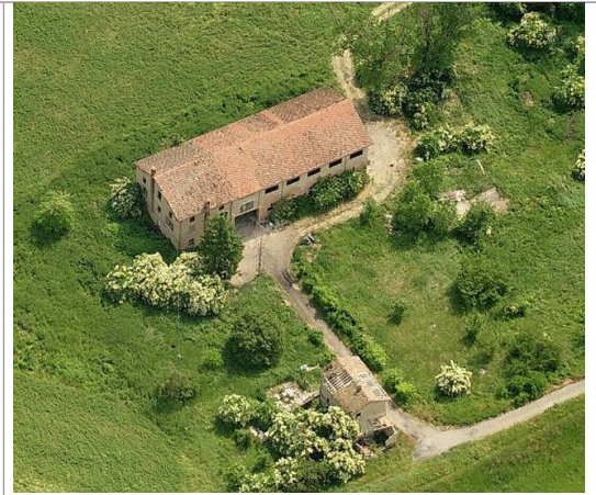
Vista da ovest
