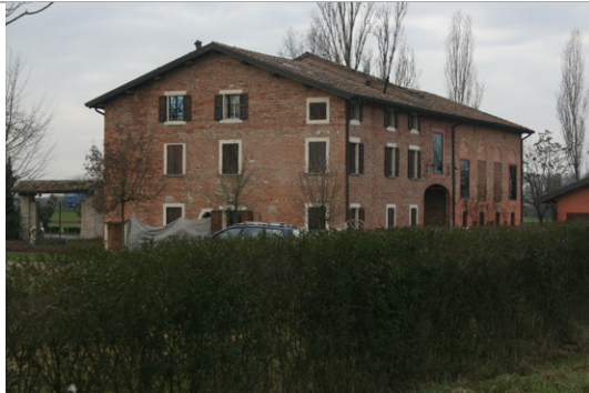
Vista dell'edificio da nord-est
