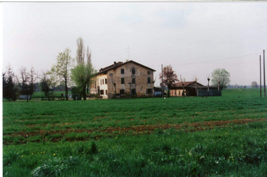
Foto Leonardi cod. 22B13-1 Vista da est del complesso, alle spalle dell'edificio principale un basso servizio oggi completamente ristrutturato ed adibito ad autorimessa e dunque non meritevole di tutela.
