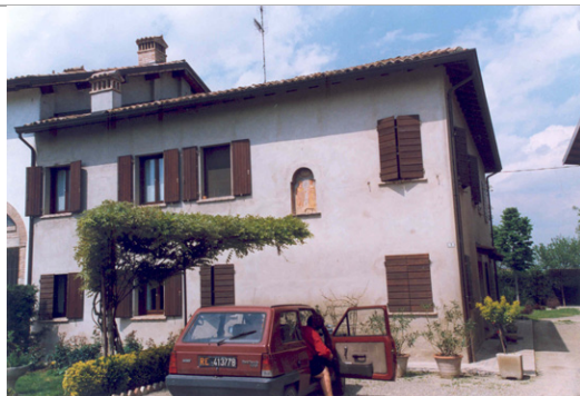
Foto Costa cod. 23A01-2 Edificio a : vista da sud-est del civile
