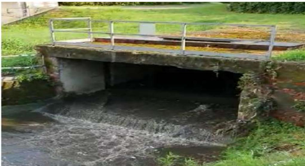
Figura 9 - Foto di scolmatore attivo in seguito a pioggia di 5 mm in 15 minuti verificatasi il giorno 11 luglio 2020. Foto cortesemente fornita da Consorzio di Bonifica dell'Emilia Centrale.
