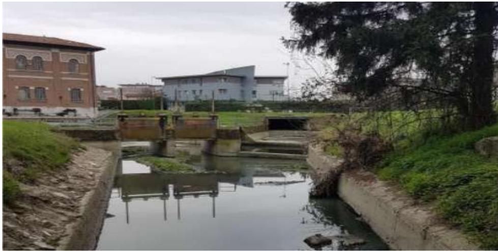
Figura 8 - Vista da valle verso monte del Canale di Reggio III e del manufatto di scarico in cui convergono i 3 scolmatori della Nave. Foto cortesemente fornita da Consorzio di Bonifica dell'Emilia Centrale.
