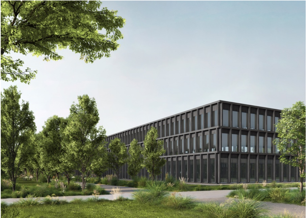
Barozzi e Veiga. Vista da nord-est
