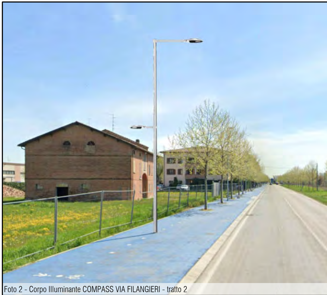
Foto 2 - Corpo Illuminante COMPASS VIA FILANGIERI - tratto 2
