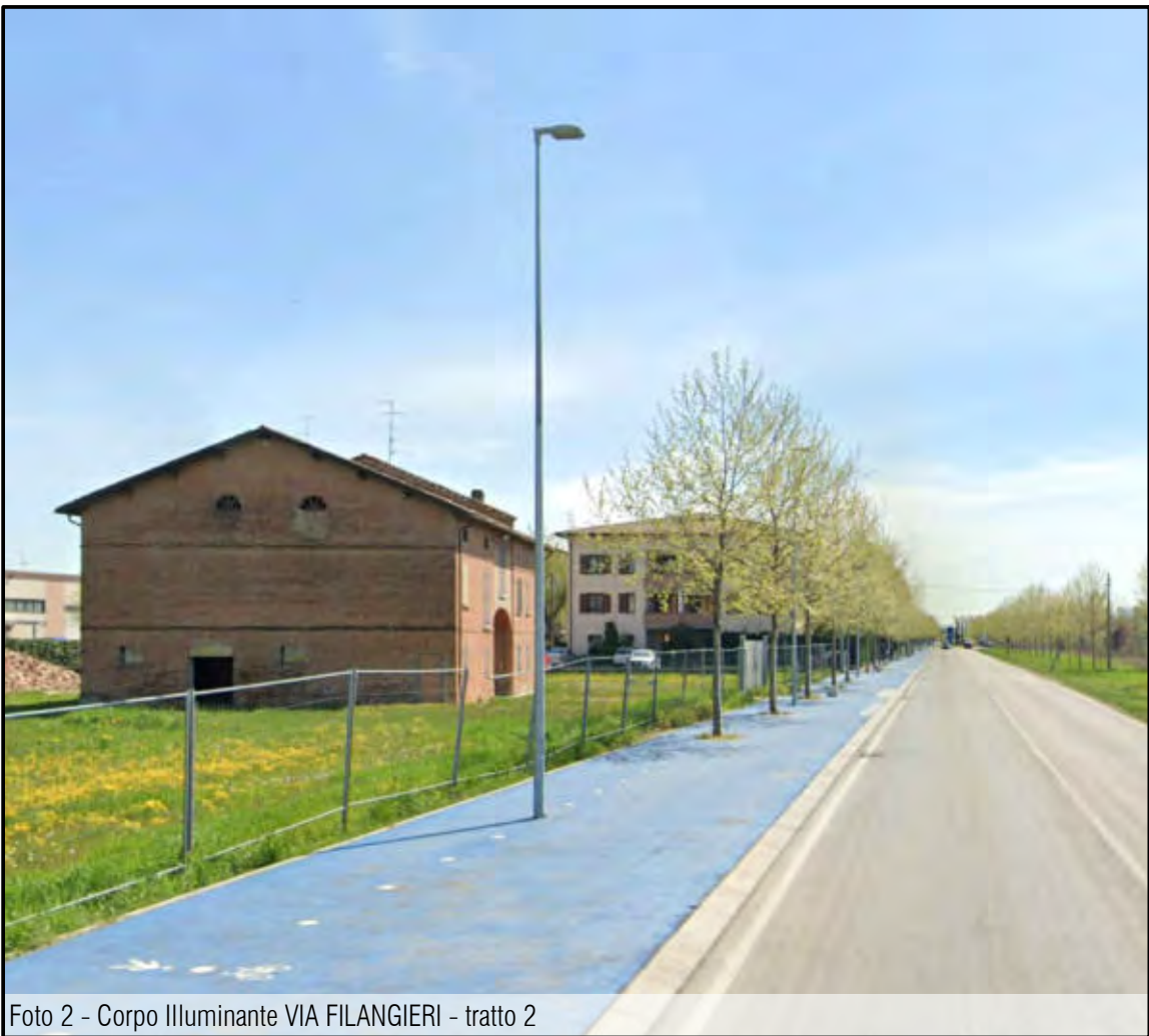
Foto 2 - Corpo Illuminante VIA FILANGIERI - tratto 2
