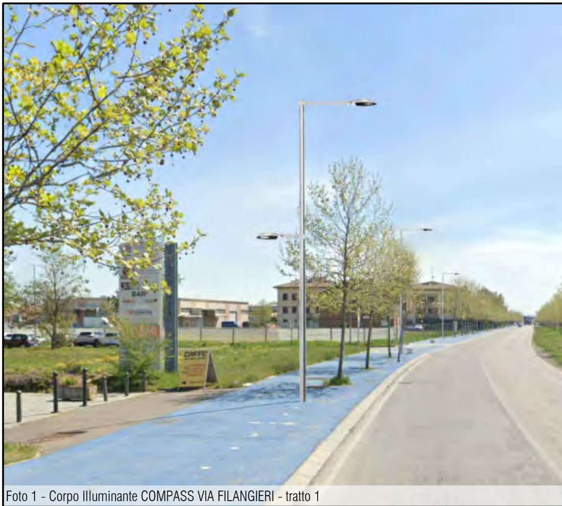
Foto 1 - Corpo Illuminante COMPASS VIA FILANGIERI - tratto 1
