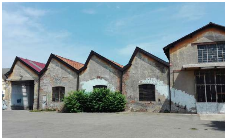
foto 32 edificio D viale Ramazzini (vista da sud - interno)
