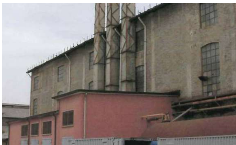
foto 11 blocco 17 centrale termica (vista facciata sud)
