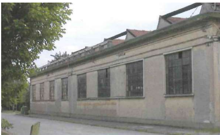
foto 1 blocco 9 magazzino spedizioni (vista facciata ovest)
