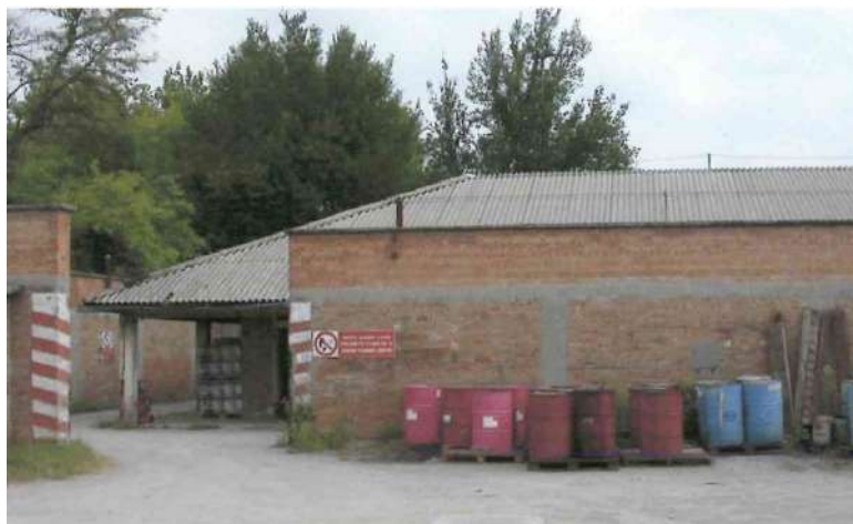
foto 20 blocco 6 magazzino vernici (vista facciata sud, ingresso)
