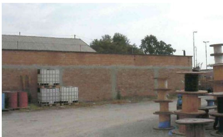
foto 21 blocco 6 magazzino vernici (vista facciata sud)
