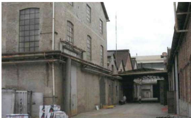
foto 10 blocchi 15 - 17 pressa quadra, carpenteria (vista facciate sud)
