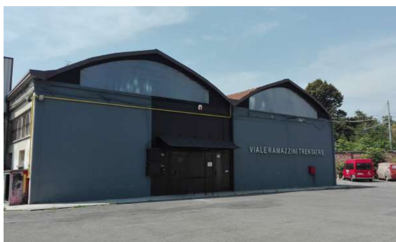
foto 30 edificio D - viale Ramazzini 33 (vista da nord est - interno)
