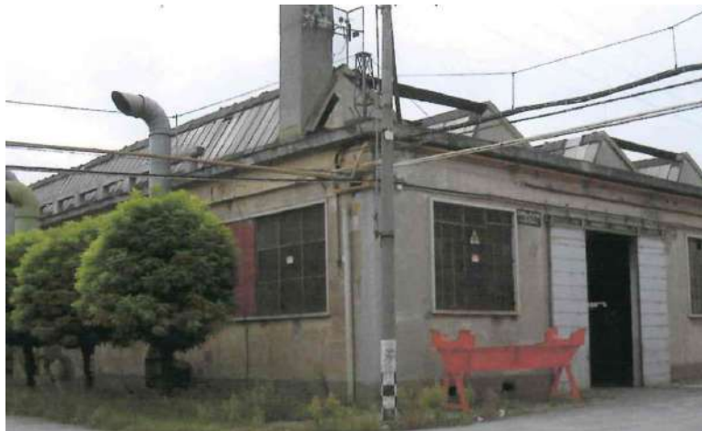
foto 2 blocco 10 sala taglio (vista facciata sud ovest)
