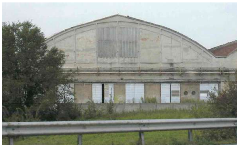
foto 17 blocco 11 reparto ferroviario (vista facciata est)
