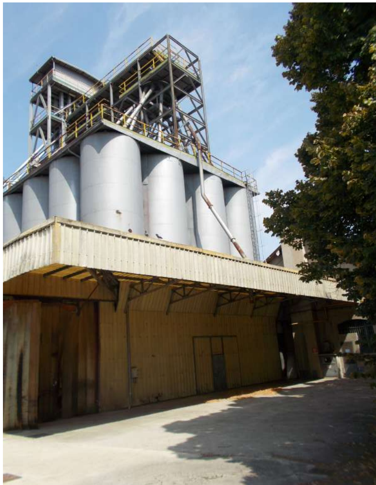
foto 28 edificio C - via Flavio Gioia 4 (vista da sud est)
