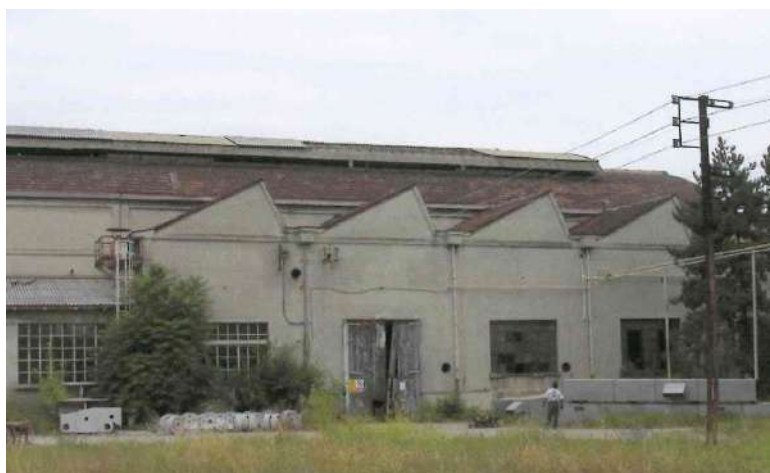
foto 14 blocco 22 modellisti e fonderia (vista facciata est)
