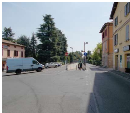
foto 35 area E - sottopasso viale Ramazzini (vista ovest)
