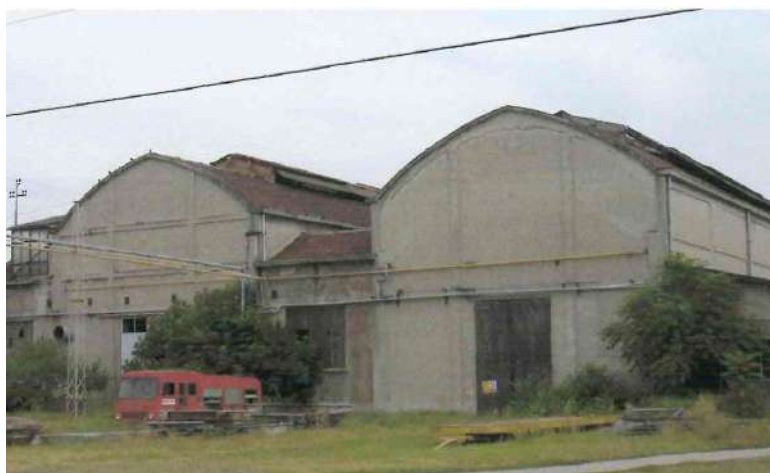
foto 13 blocco 22 modellisti e fonderia (vista facciata sud)
