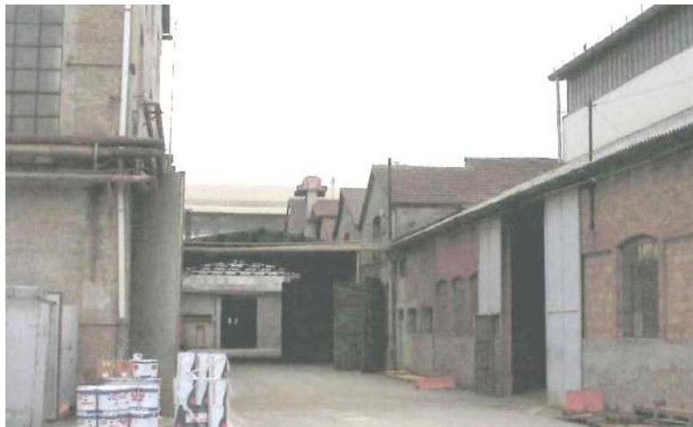
foto 9 blocchi 15 - 17 pressa quadra, carpenteria (vista facciate sud)
