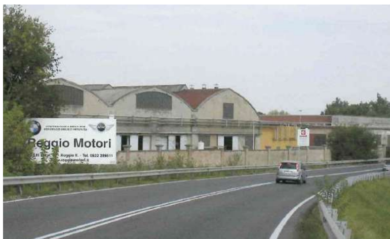
foto 18 blocco 11 linea carrelli (vista facciata est)
