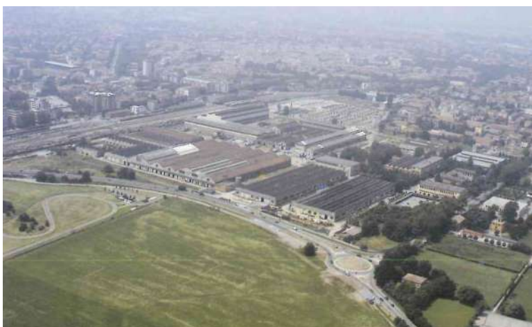
foto 3 aerea_vista da nord est
