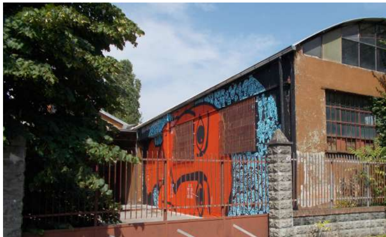
foto 24 edificio B - via Flavio Goia 22 (vista da sud est)
