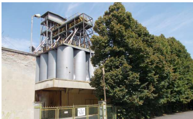
foto 29 edificio C - via Flavio Gioia 4 (vista da sud est)
