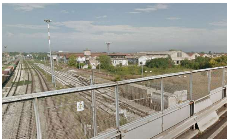
foto 19 blocchi 11 - 12 reparti meccanica e prove (vista facciata sud est)
