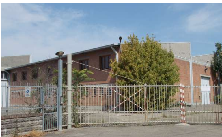
foto 23 edificio A - via Flavio Goia 24 (vista da sud est)
