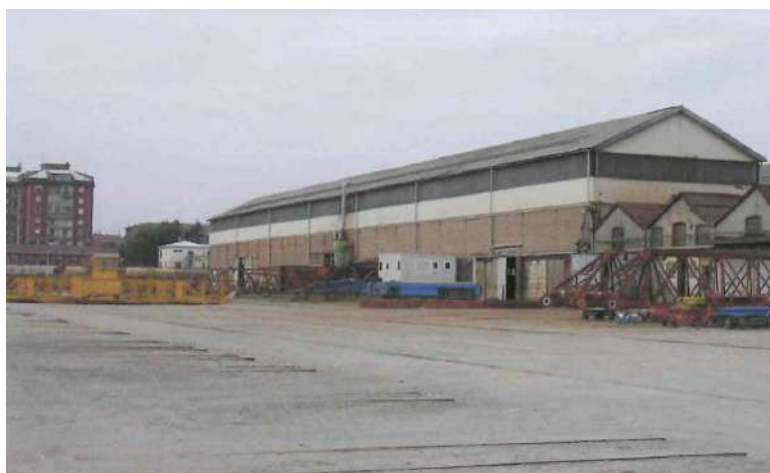
foto 4 blocco 15 carpenteria (vista facciata est)
