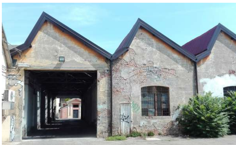
foto 33 edificio D viale Ramazzini (vista da sud - interno)
