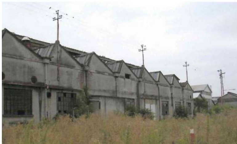
foto 12 blocco 22 modellisti e fonderia (vista facciata ovest)
