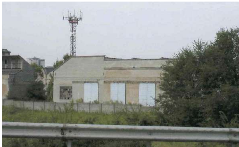
foto 16 blocco 11 reparto ferroviario (vista facciata est)
