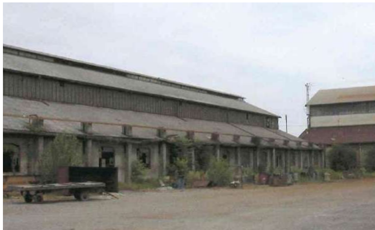
foto 6 blocco 19 fonderia ghisa ora Tecnopolo (vista facciata est)
