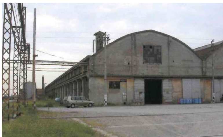
foto 3 blocco 11 linea carrelli (vista facciata ovest)
