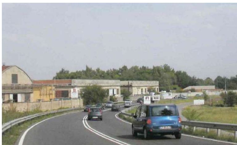
foto 22 blocchi 9 - 10 sala taglio (vista facciata est)
