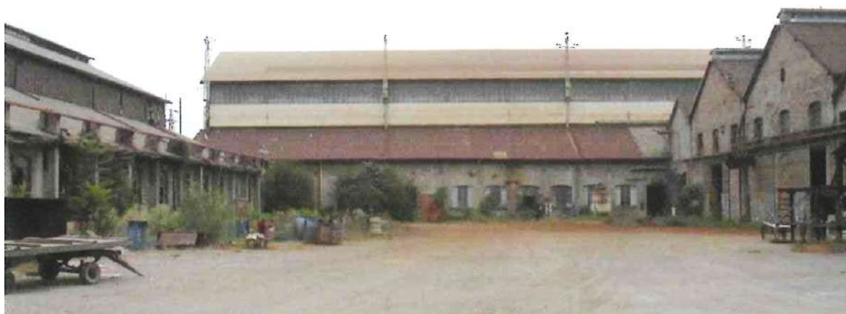
foto 8 blocco 18 caldareria (vista facciata sud), ai lati sono visibili blocchi 19 (ora Tecnopolo) e 17
