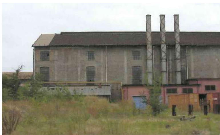
foto 7 blocco 17 pressa quadra, centrale termica (vista facciata sud)
