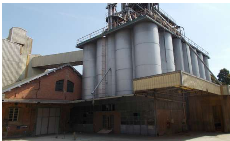
foto 27 edificio C - via Flavio Gioia 4 (vista da sud ovest)
