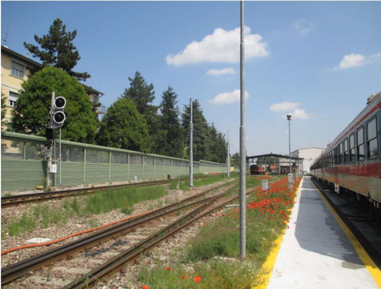
Foto n.6: Veduta della tettoia interna al Deposito /Officina MA-FER per il servizio di rifornimento gasolio delle locomotive
