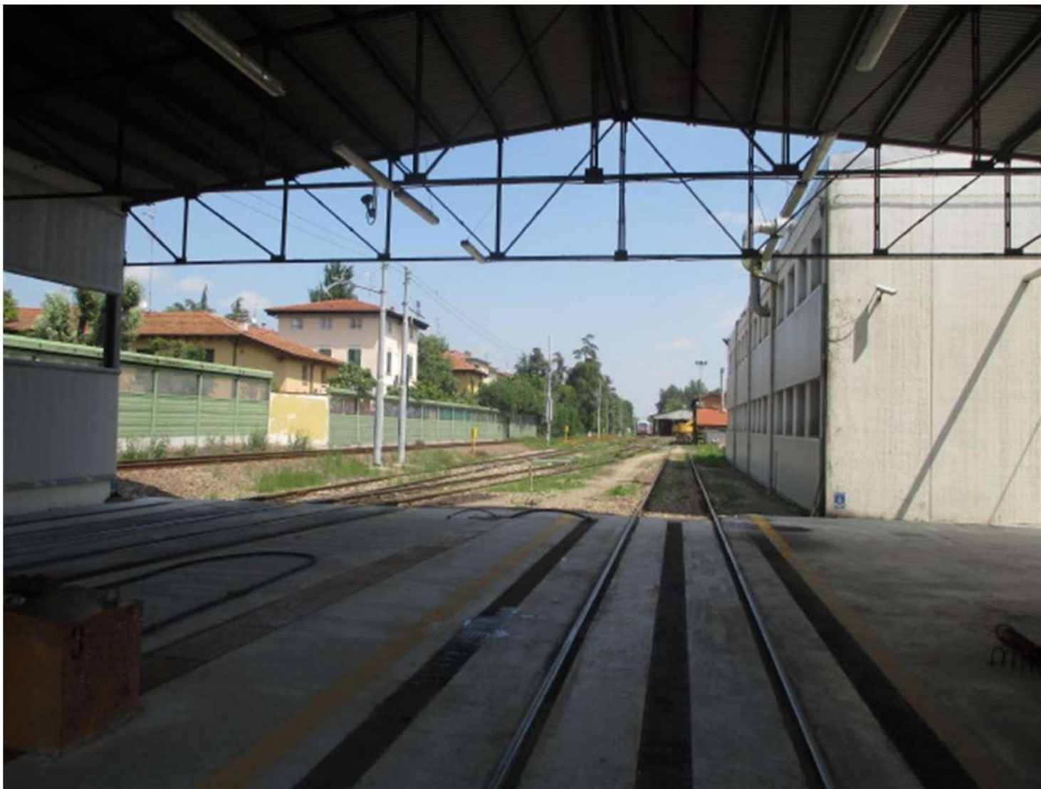
Foto n.8: Tettoia presso punto di rifornimento carburanti all'interno del Deposito/Officina MA-FER
