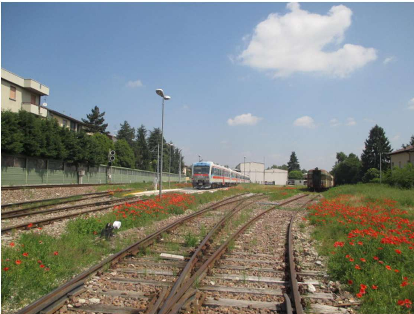
Foto n.4: Veduta in direzione nord del Deposito/Officina MA-FER con la nuova platea di lavaggio ed altri binari di sosta treni/locomotive
