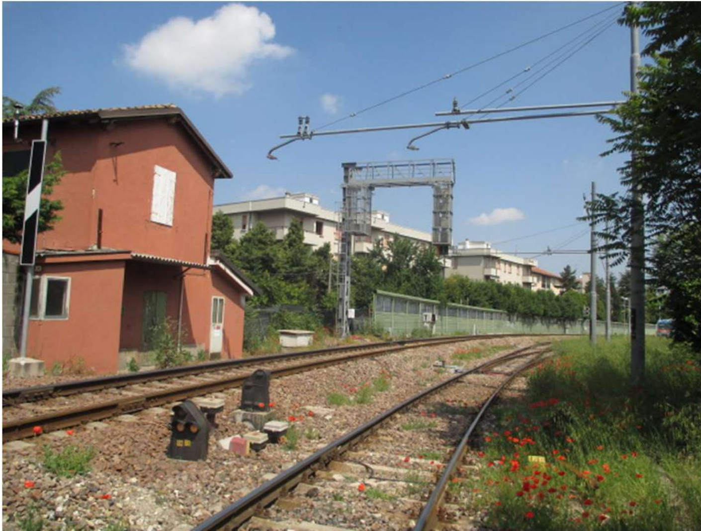
Foto n.2: Ubicazione dell'eventuale PL in direzione nord (Guastalla) con presenza di segnali bassi ferroviari , pali della prevista elettrificazione e sulla destra, deviatoio del deposito MA-FER
