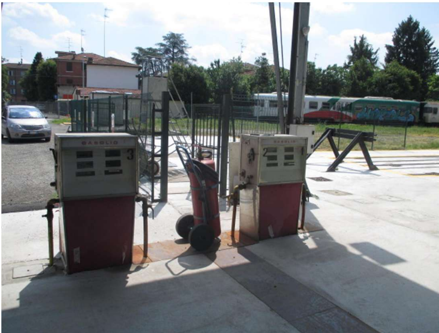
Foto n.7: Pompe di rifornimento gasolio all'interno del Deposito/Officina MA-FER
