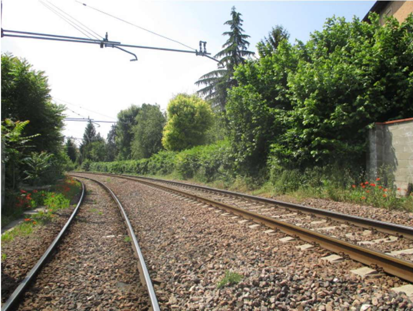
Foto n.3: Ubicazione dell'eventuale PL in direzione sud (Reggio E.) con presenza di dislivello tra il binario della linea Reggio E.-Guastalla e il raccordo del Deposito MA-FER
