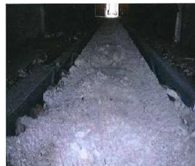
**Manufatto 42:** risulta inscritto in un rettangolo di 11x7 m (profondità non accertabile), completamente riempito di rifiuti derivanti da crolli e demolizioni di strutture del capannone (calcestruzzo e laterizi), oltre a tubi e pannelli di plastica, listelli e tavole di legno, spezzoni in ferro.
