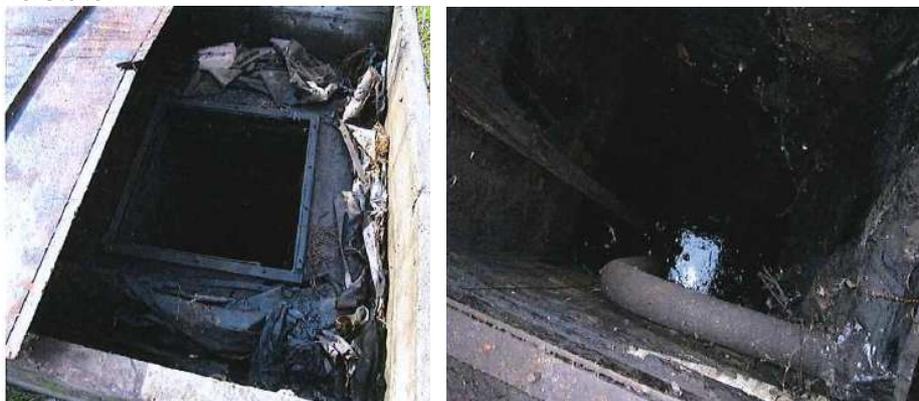
**Cisterna 4 (all'esterno del Capannone 18 lungo il lato sud):** struttura in metallo contenente acqua, che risulta interrata ma aperta, in quanto la parte superiore è mancante forse a causa di un'asportazione accidentale. Il fondo si attesta ad una profondità di circa 1,70 m dal piano campagna. Sullo strato d'acqua non si apprezzano iridescenze o macchie d'olio in galleggiamento.
