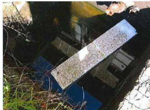
**Cisterna 3 (all'esterno a nord-ovest):** è visibile per la presenza di un manufatto in calcestruzzo che emerge dal terreno avente coperchio metallico. Il fondo si attesta intorno a 3,00 m di profondità da testa pozzo e sul fondo sono presenti circa 30 cm di olio combustibile. Le pareti sono in calcestruzzo e sembrano in buono stato.
