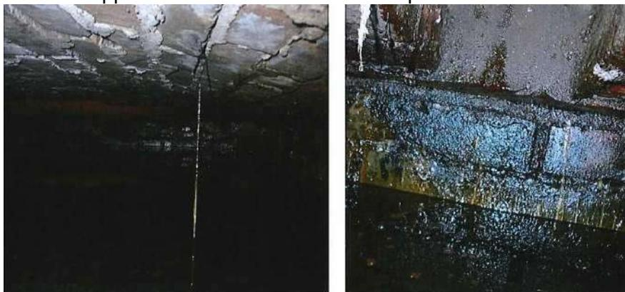
**Cisterna 6:** posta circa a metà della lunghezza del capannone verso il lato ovest dell'edificio. Si tratta di una cisterna avente un'apertura centrale ed una seconda piccola apertura più esterna. La cisterna risulta riempita da olio o acqua ed olio. Il fondo si attesta a circa 1,30 m di profondità dal pavimento.
