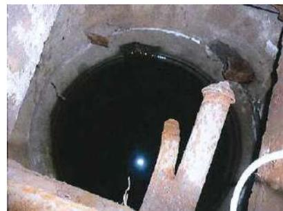
**Cisterna 5:** all'estremità occidentale del reparto "Trattamenti termici" si osserva una fessura sul pavimento di circa 1,30x0,15 m. Questa fessura dà accesso ad una cisterna interrata profonda 1,70 m completamente riempita di olio minerale. Le dimensioni della cisterna sono stimabili in 3x1,30 m circa. Le pareti sono in laterizio e appaiono estremamente intrise di prodotto oleoso.
