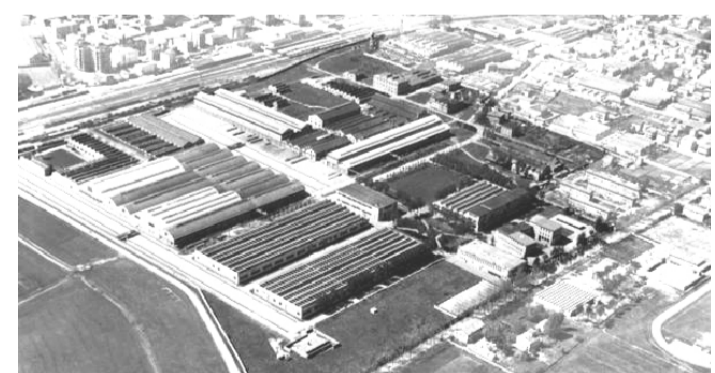
2008 _vista dell'insediamento produttivo
