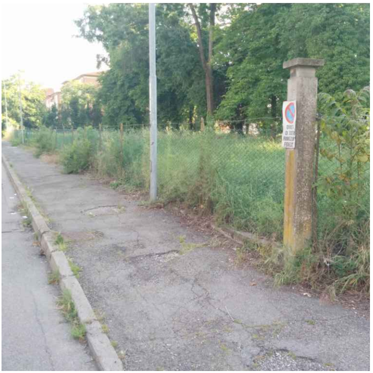
FOTO 2: Recinzione esistente Sezione C
