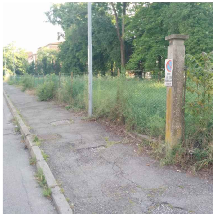
FOTO 2: Recinzione esistente Sezione C
