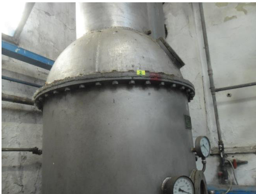
Foto 4: campione 2, guarnizione al corpo bollitore n. 6
