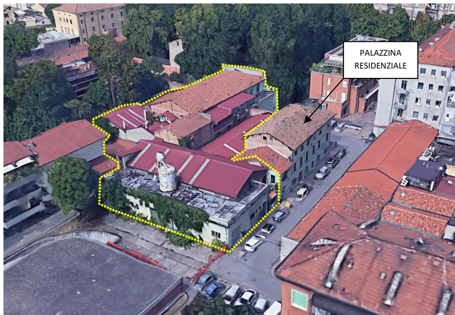
Immagine 6 – Vista dal lato est con individuazione (perimetro giallo) dell'area oggetto di demolizione
