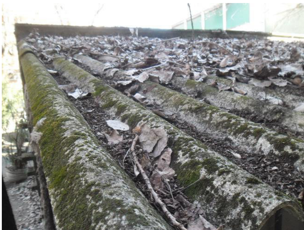
Foto 2: tettoia, particolare e stato di conservazione scadente
