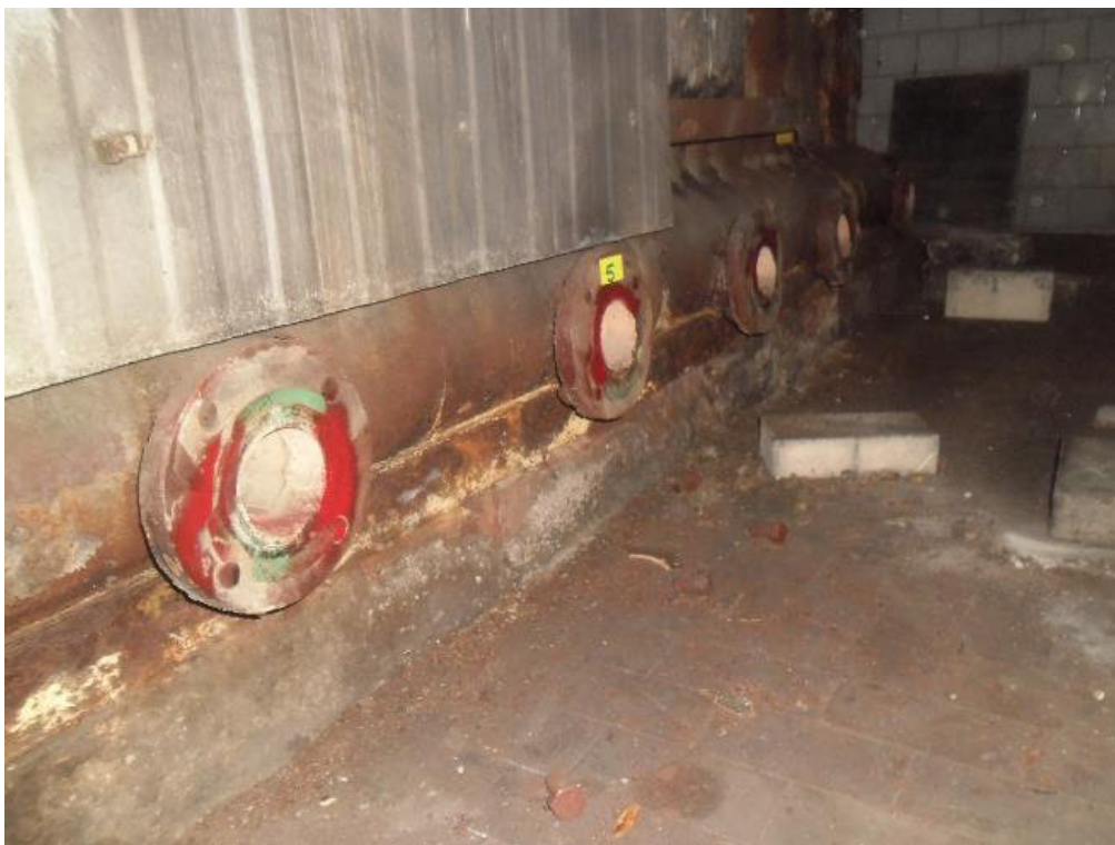
Foto 7: campione 5, guarnizioni senza amianto
