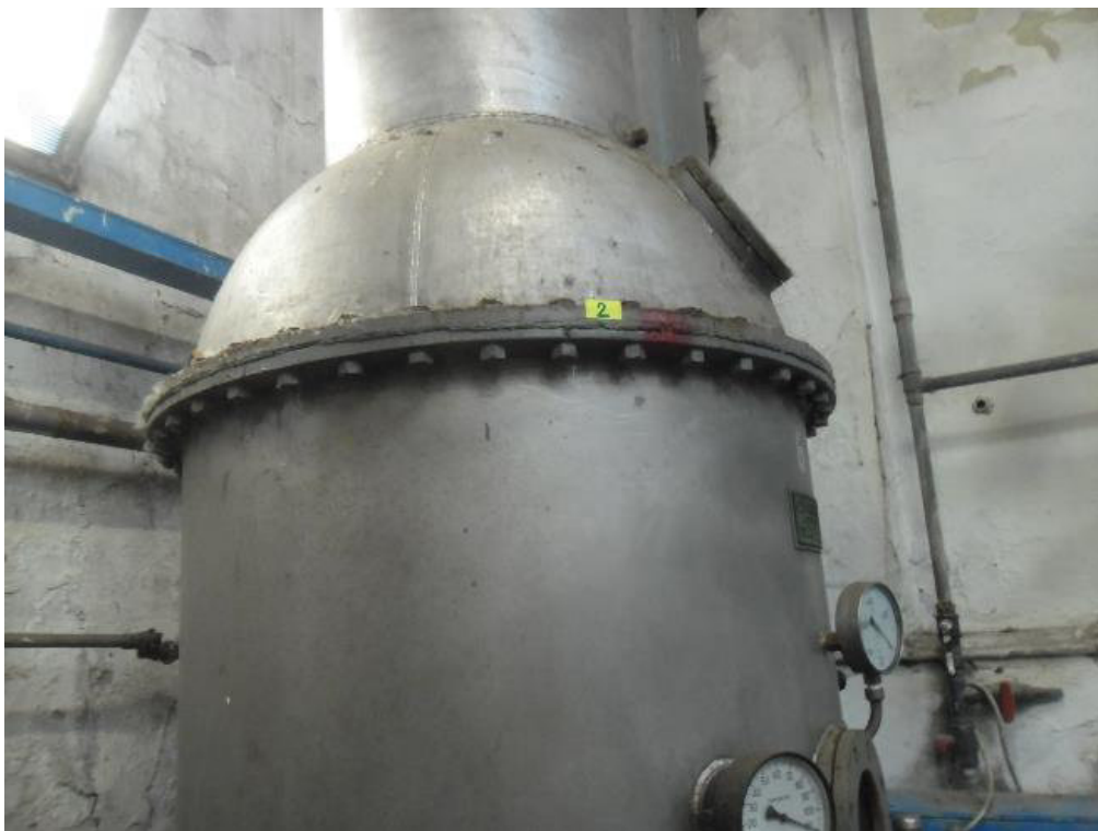
Foto 4: campione 2, guarnizione al corpo bollitore n. 6
