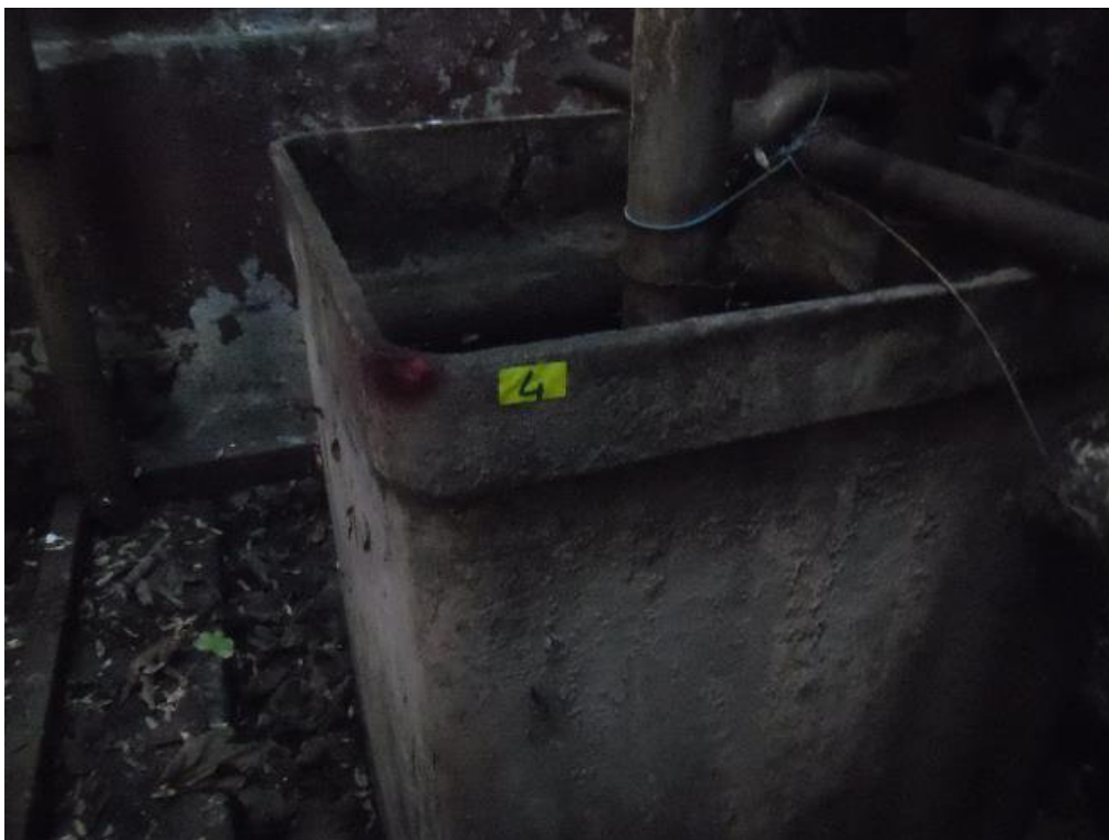
Foto 6: campione 4, serbatoio vistosamente ammalorato
