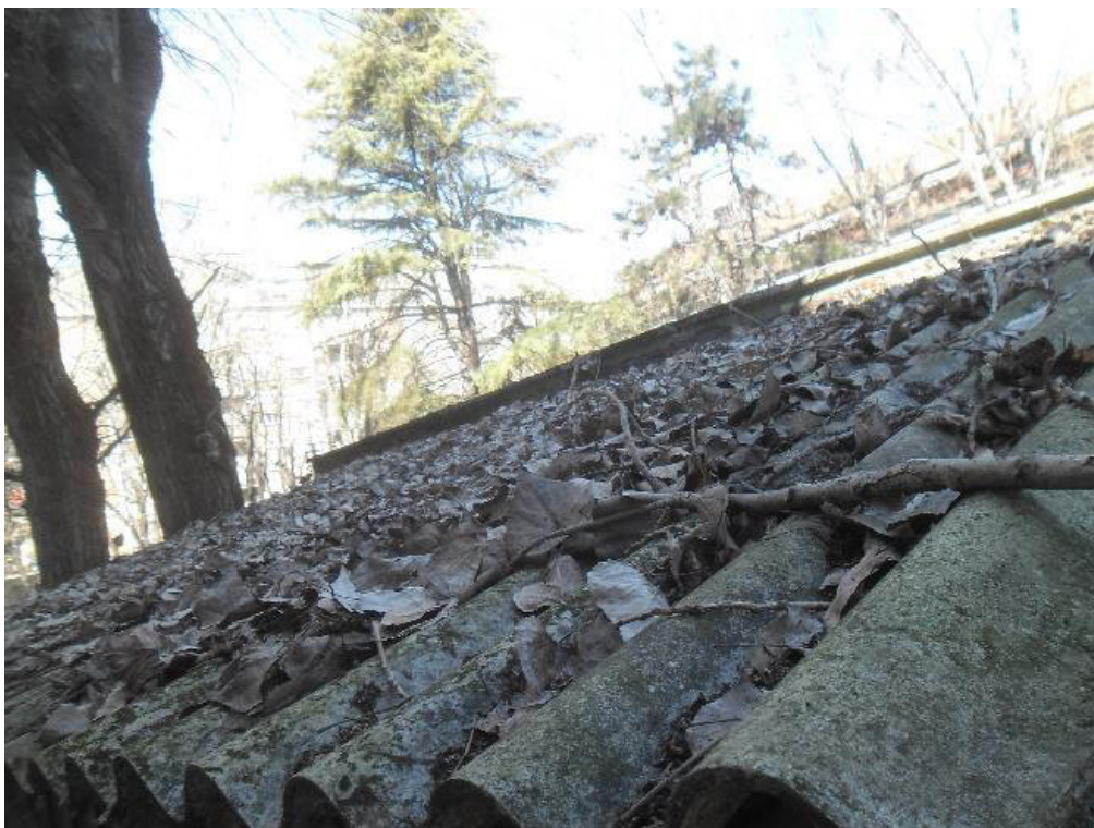
Foto 3: tettoia, particolare e stato di conservazione scadente
