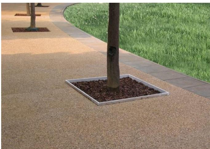
Pavimentazione cementizia con inerte a vista
