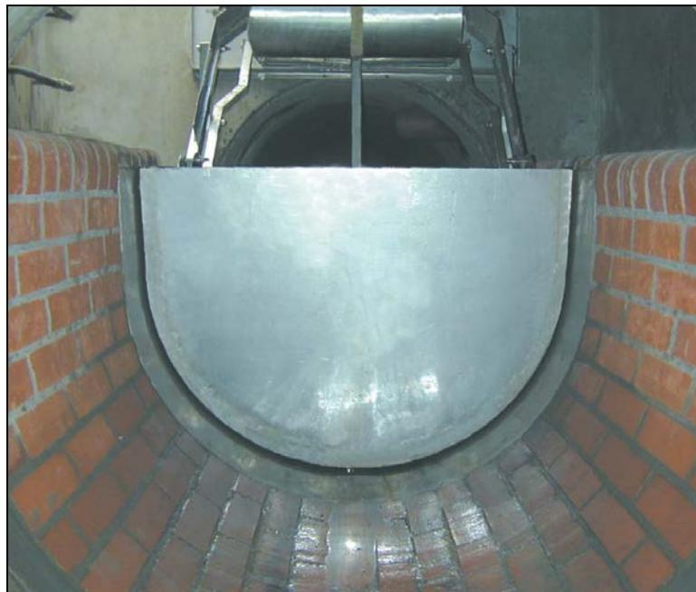
Figura 13 / bis – Caratteristiche del dispositivo di autopulizia che è possibile prevedere a monte della vasca di laminazione interrata: pianta e sezioni; fasi di funzionamento (posizione base, riempimento, inizio cacciata, fine cacciata); immagine di paratoia montata nel pozzetto.
