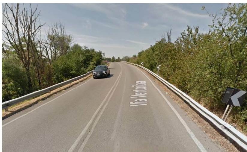
CAVALCAVIA DI VIA VERTOIBA
