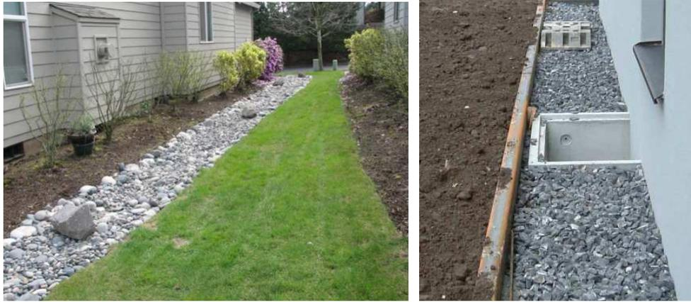
Figura 5. Esempi di tubi drenanti posti lungo il perimetro dell'edificio nascosti da ciottoli. Tale elemento può integrarsi pienamente nel progetto architettonico. [http://www.homeownercare.com]
