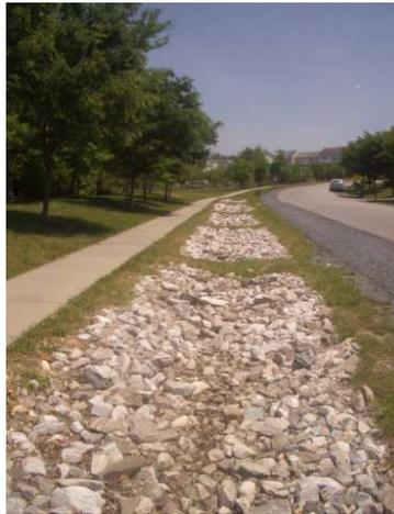
Figura 14. Esempio di canali infiltranti\_ <http://sustainablestormwater.org>
