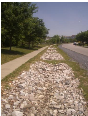
Figura 14. Esempio di canali infiltranti_ http://sustainablestormwater.org
