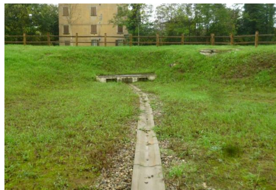
Figura 13. Vasca infiltrante recentemente realizzata a Canali (Reggio Emilia). Si noti la canaletta alla francese, realizzata con pendenza di circa 1%, impostata su un canale di infiltrazione a cielo aperto
