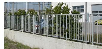
Esempio di recinzioni con pannelli modulari a profili verticali tubolari e cordolo in cls
