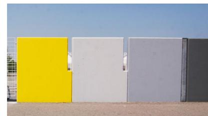
Esempi di struttura schermante costituita da pannelli in cemento colorato
