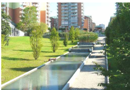
Esempio riqualificazione urbana in cui l'acqua diventa elemento orditore dello spazio urbano _Torino _riqualificazione Spina 3
