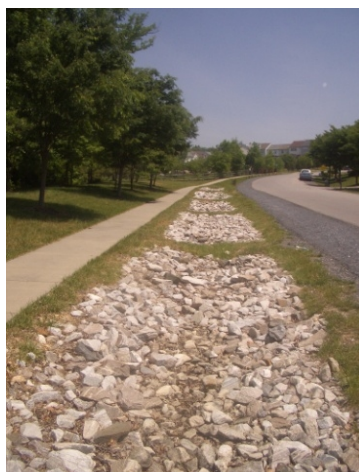
Figura 14. Esempio di canali infiltranti_ http://sustainablestormwater.org
